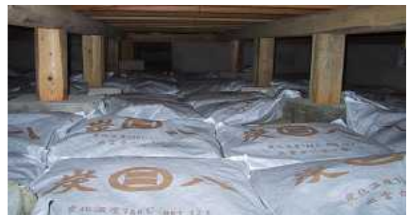
写真2 床下用調湿木炭敷設例
