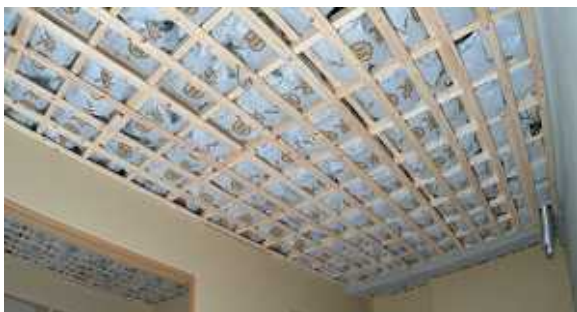
写真1 天井用調湿木炭敷設例
